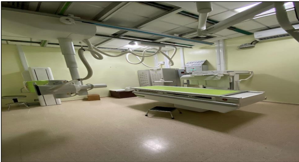
Figura 2. Instalaciones del Hospital
